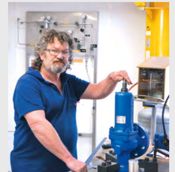
Lokale Ventileinstellung am Zentrallager in Toulouse
