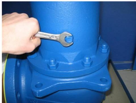
Abb.2 Verschließen der Entwässerungsbohrung
