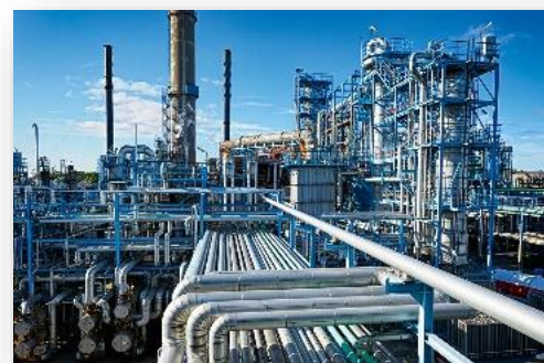
Pressão na planta industrial de clientes ??? kPa / bar(g)
